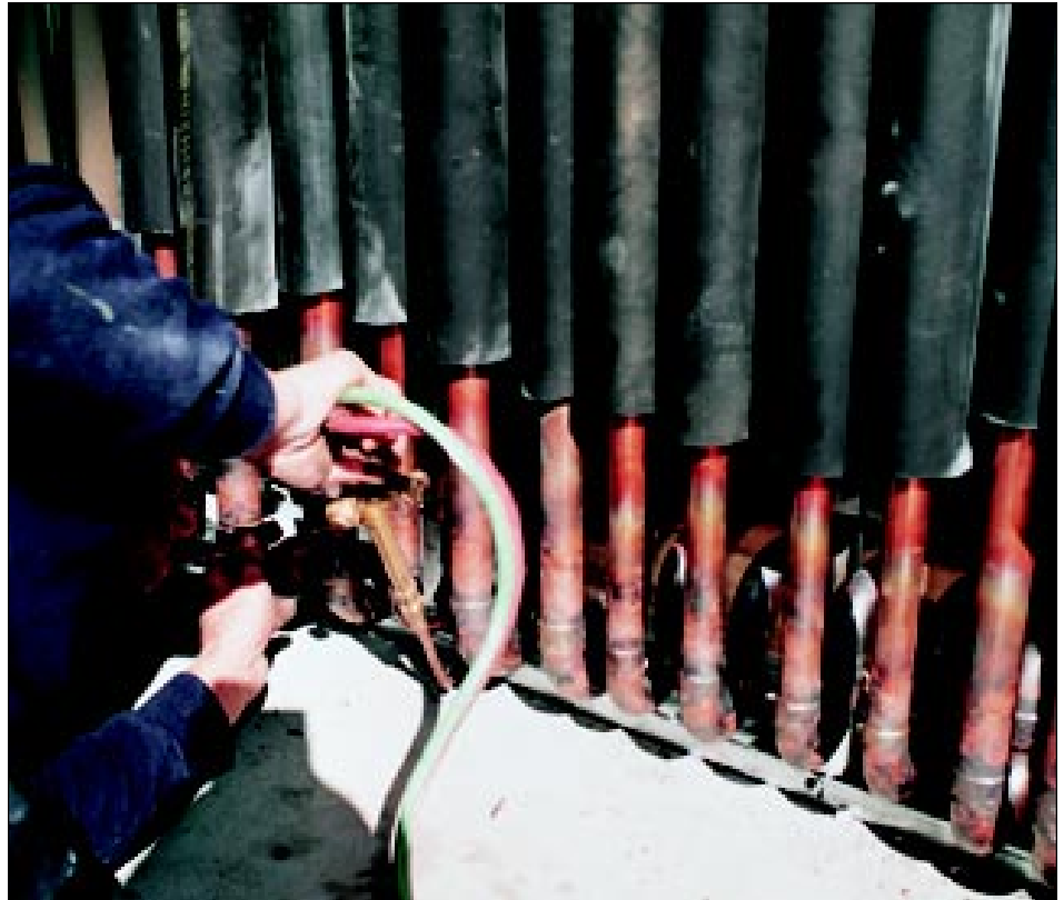
Quelques-uns des joints ont été brasés dans des espaces restreints, tel qu'illustré sur cet étage au niveau de transition aux conduites verticales qui descendent jusqu'au rez-de-chaussée.
