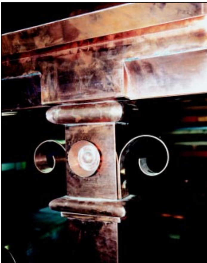
Ce détail de la rampe à la tour de Harvard montre les diverses méthodes de fabrication et les matériaux utilisés tels que les feuilles et les barres de cuivre.
